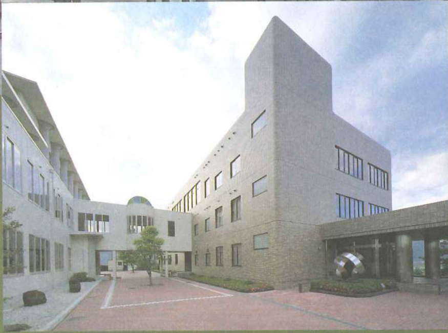
管理棟 教室棟の北側に95年7月竣工。鉄筋コンクリート3階建て（一部地下1階）。1階に事務室、職員室、校長室、2階に図書室、保健室、進路指導室、3階に会議室（多目的ホール）などが設けられています。
