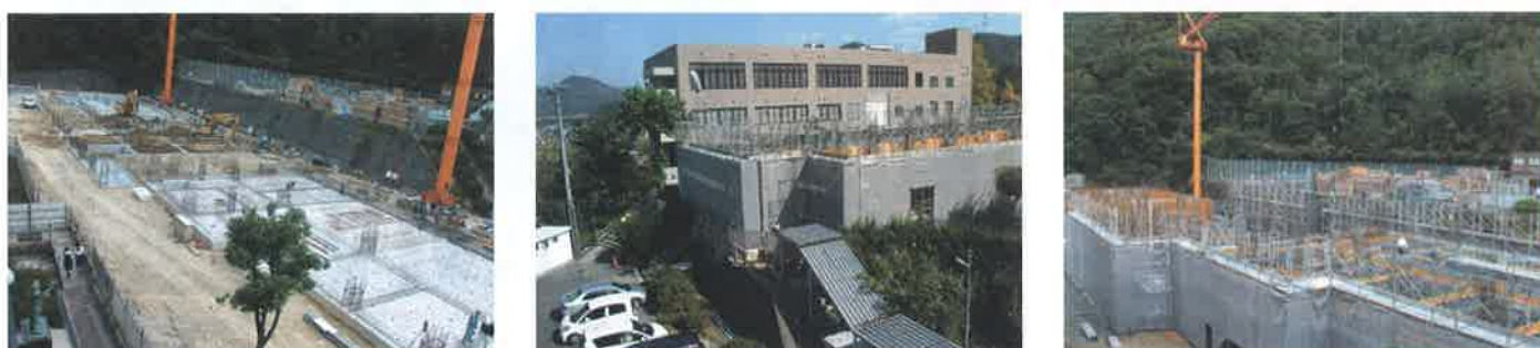
平成23年7月～平成24年7月 新校舎建築
