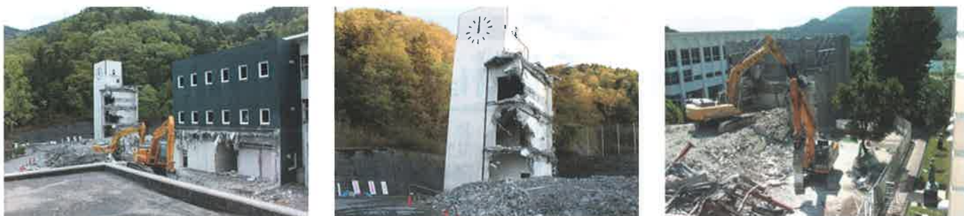
平成23年4月 旧校舎解体作業開始
