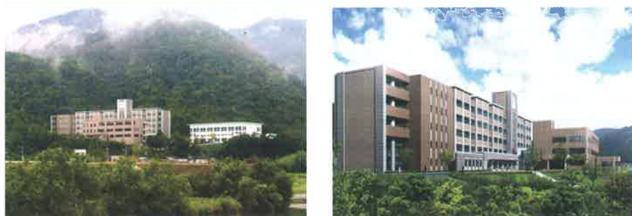
平成24年7月 新校舎完成
